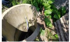
Aさん宅では池の湧水減少、 濁りが発生(写真左) 井戸はトンネル工事のダイナ マイトによる発破振動で壁が 崩れたので土砂の除去を余儀 なくされた(写真右)
