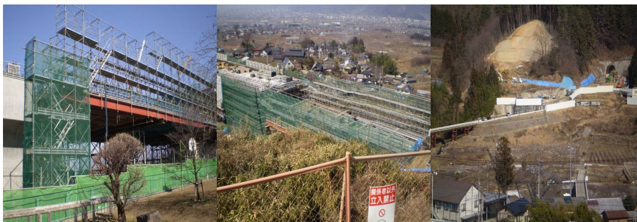
（市街地での架橋工事）
