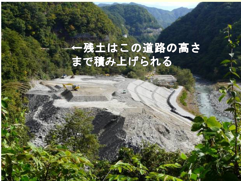
今回の関連工事で発生した残土の仮置き場
