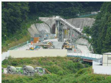
建設中のトンネル工事現場(山梨県)
