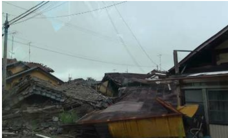
倒壊したままの住宅(双葉町)
