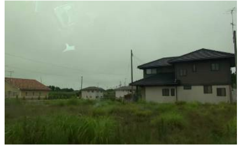
新築なのに住めない住宅(双葉町)
