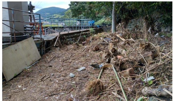
興津川承元寺取水口
