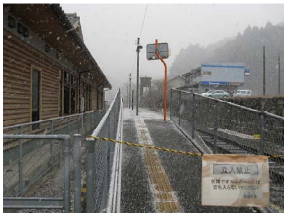
《立ち入り禁止の伊勢奥津駅－奥には給水塔が》
