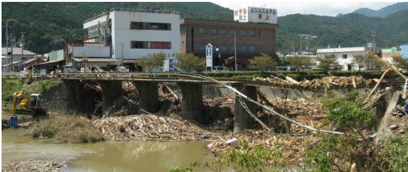
【台風12号により被害を受けた『熊野市駅構内の井戸川に架かる鉄橋』】
